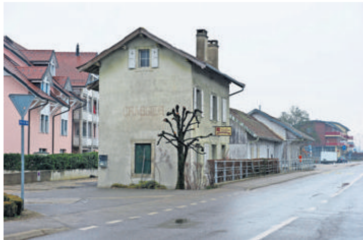
En mauvais état, les bâtiments de la gare seront démolis. Des immeubles prendront place sur la parcelle. VANESSA CARDOSO
